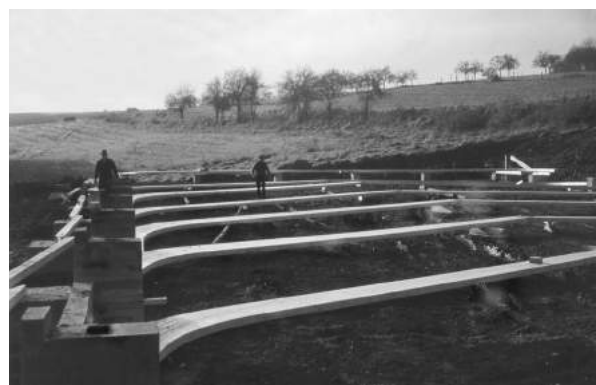
Abb. 93: Bau der Reithalle auf dem Gelände der Grube Laura
