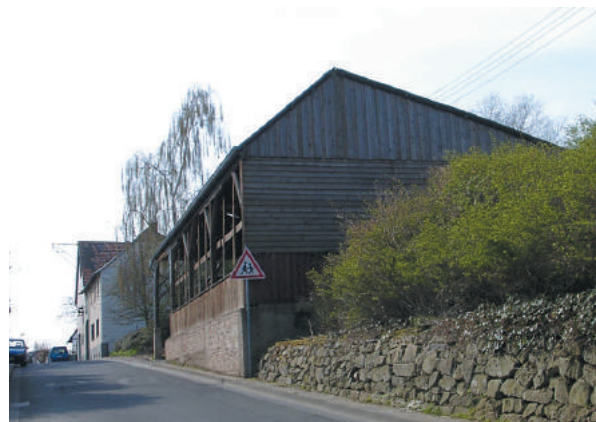
Abb. 19: Die Hofstelle des ehemaligen Kapitelshofes 2006
