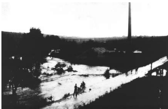
Abb. 89: 1931 – Wassermassen an der Grube Laura
