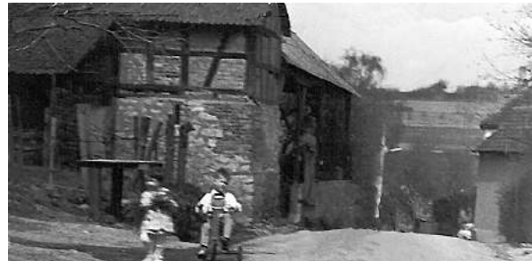
Abb. 18: Kapitelshof mit Stalltrakt (Abbruch ca. 1980)
